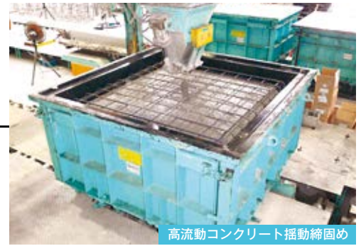
高流動コンクリート揺動締固め
